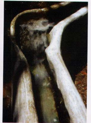
صهريج مياه الأمطار
